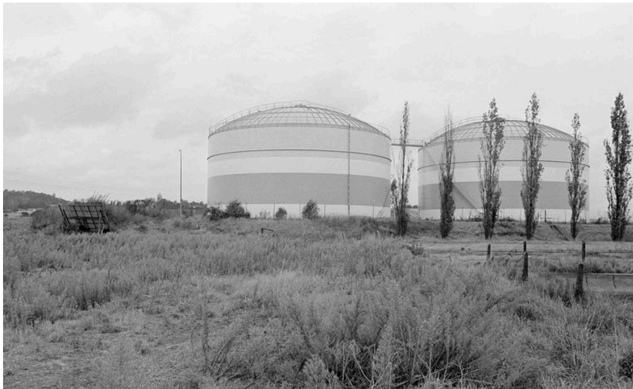
Les silos, vue générale.
