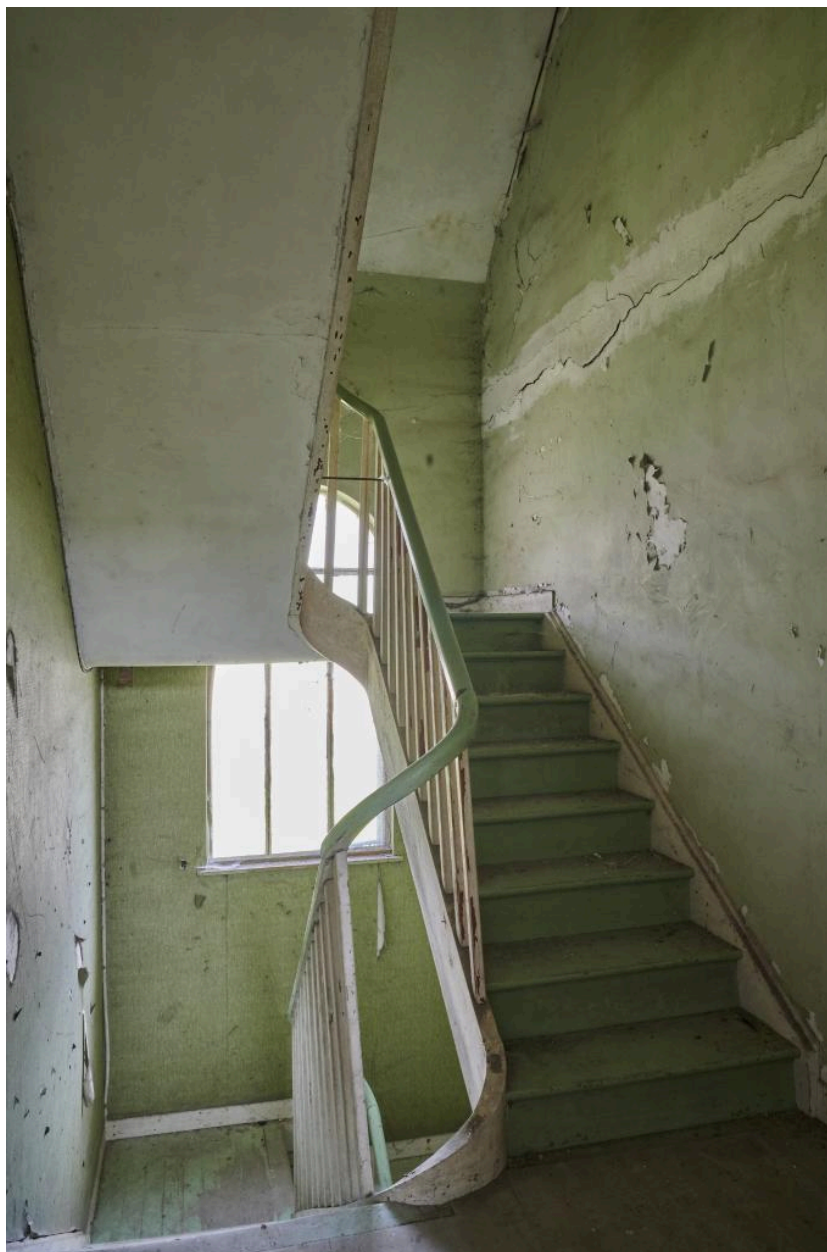
Escalier rampe sur rampe du logement du chef d'élevage.
