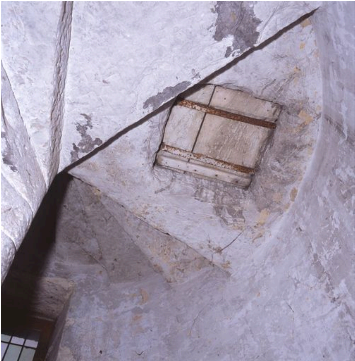
Corps de logis médiéval, intérieur, tourelle d'escalier (ouest), montée entre le 1er et le 2e étage : trappe fermant la trémie.
