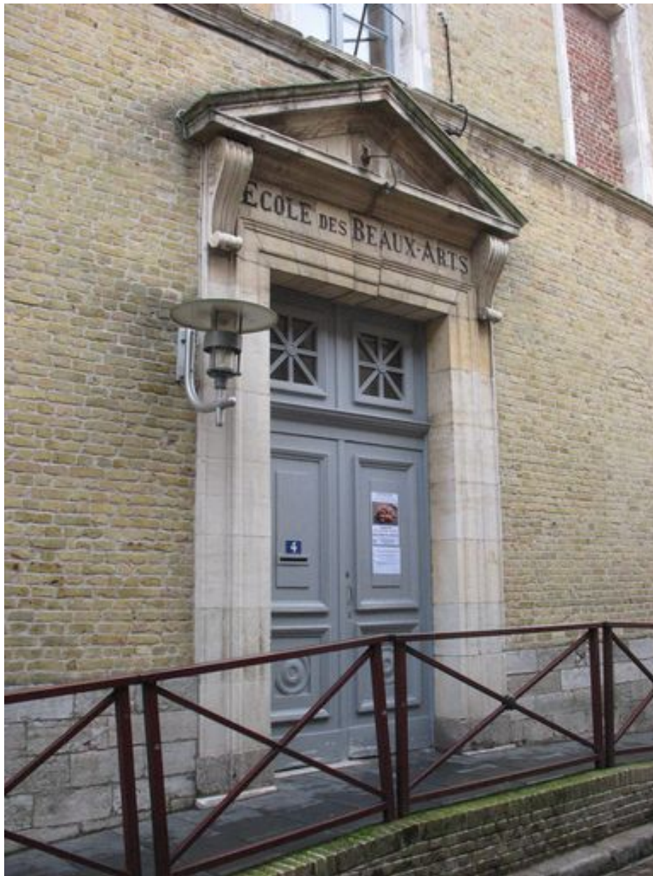
Façade sur rue : portail
