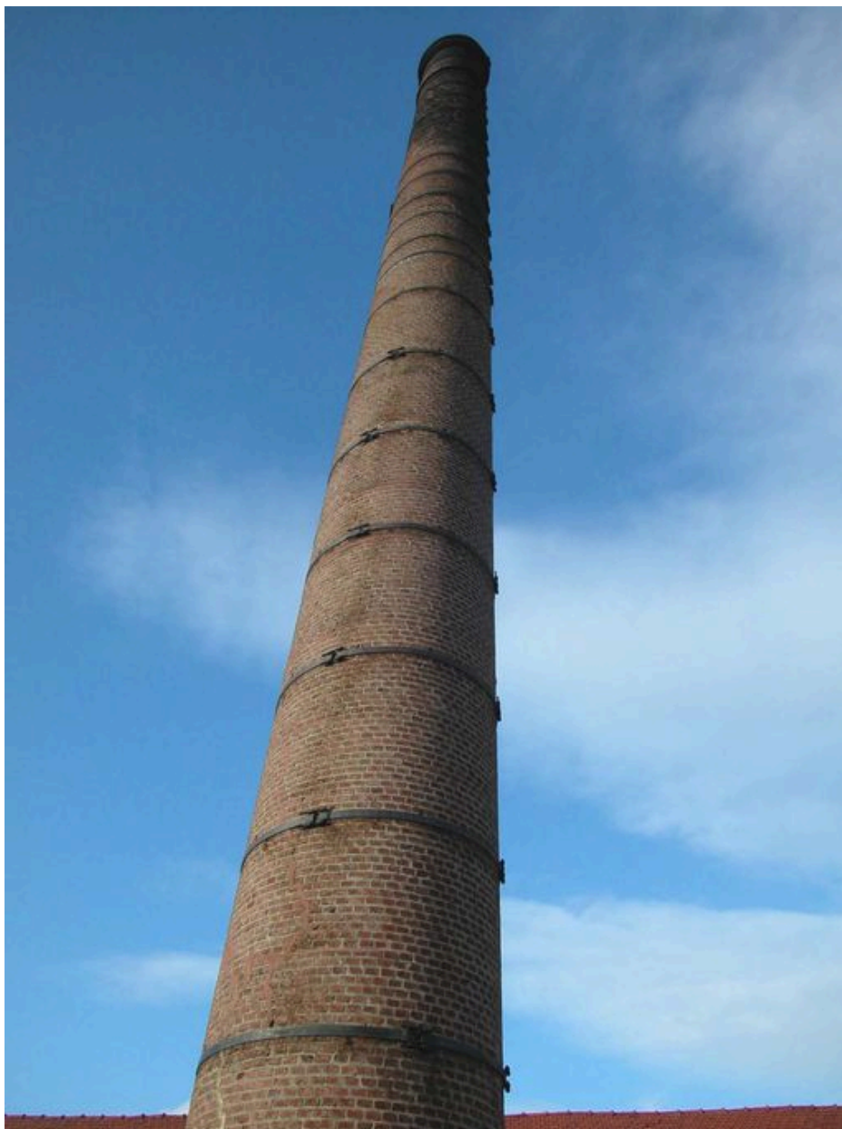
Vue de la cheminée d'usine.
