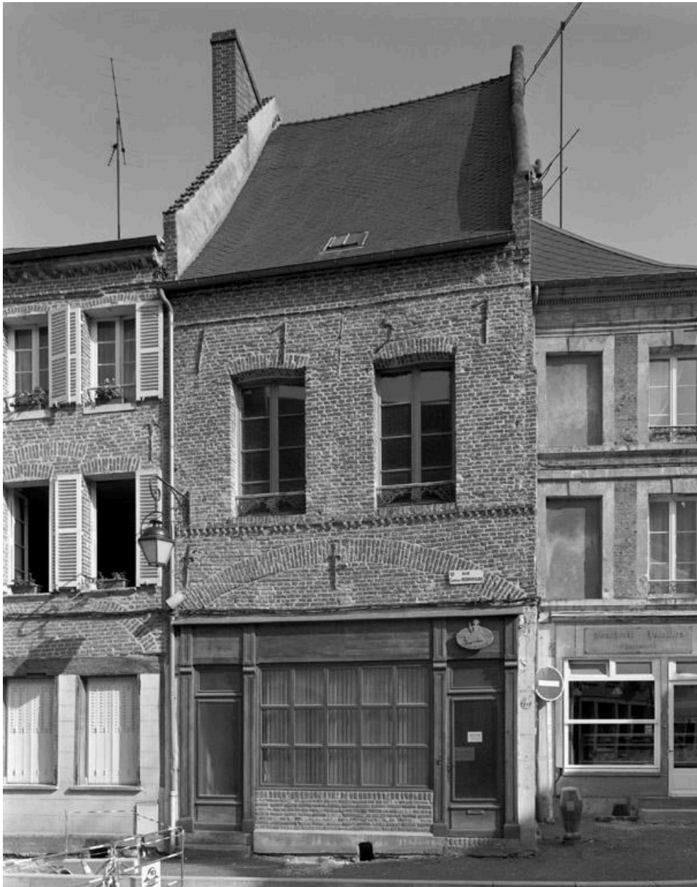
Vue de la façade sur rue.
