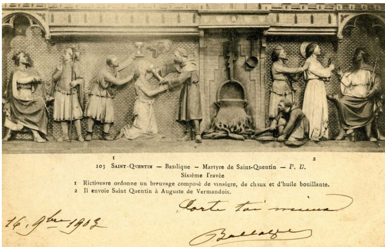
Vue de la sixième travée sud, vers 1900 (collection particulière).
