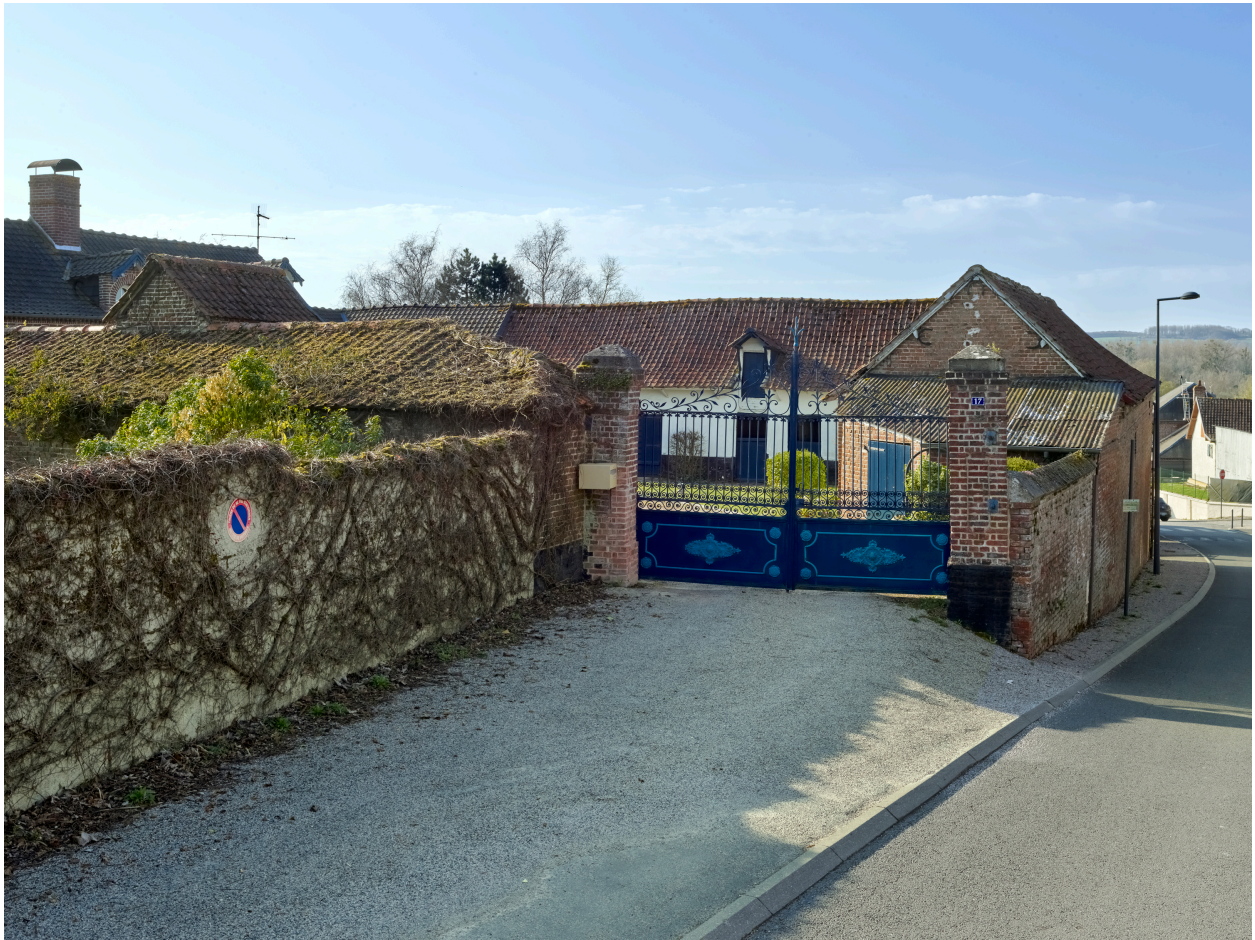
Vue de l'entrée de la ferme, depuis le nord.
