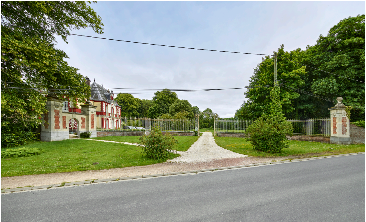
Vue de l'entrée, depuis la rue.
