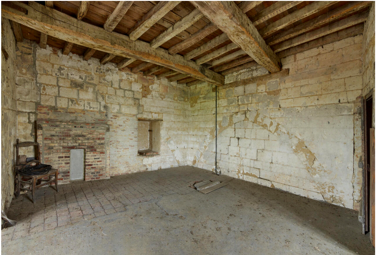
Vue intérieure de l'ancienne salle des gardes du beffroi.
