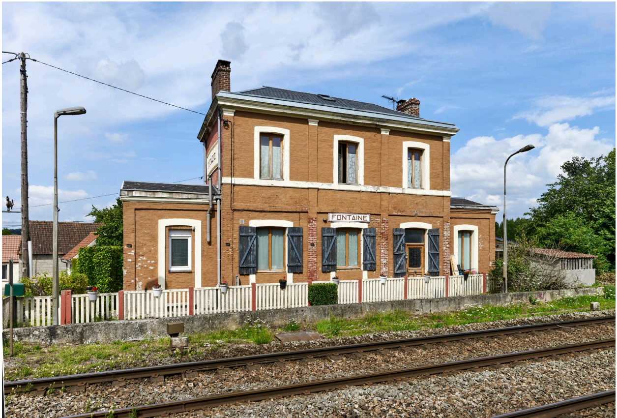
Vue sud de la gare.
