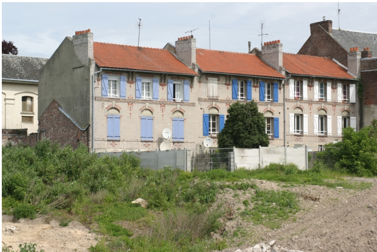
Façade postérieure des logements de contremaîtres.
