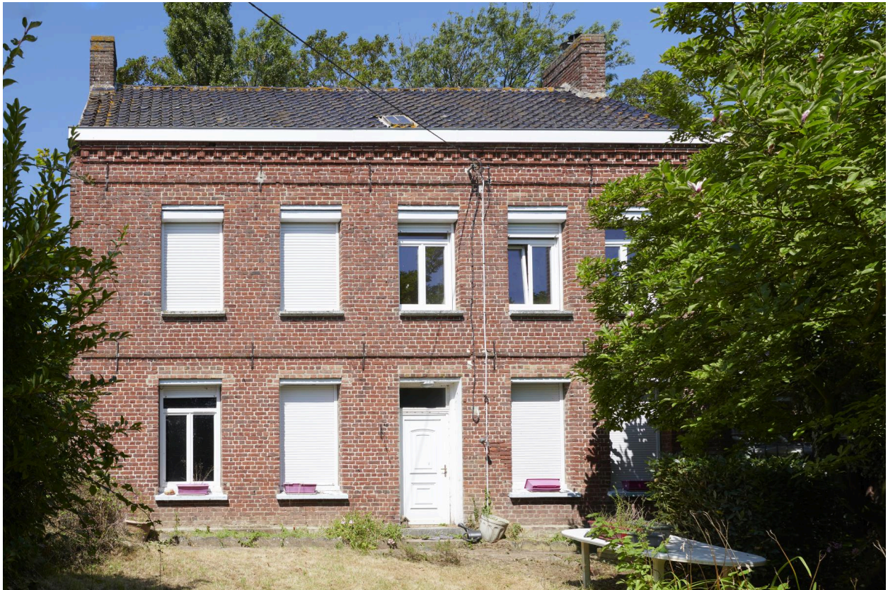
Façade principale (sud) du presbytère.
