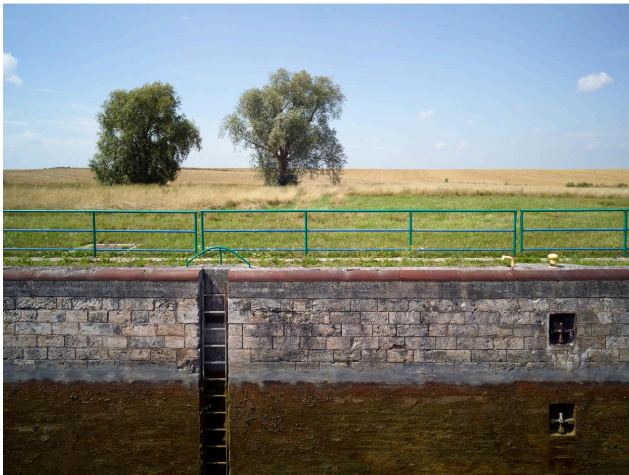
Site d'écluse n°7 de Graincourt-lès-Havrincourt.
