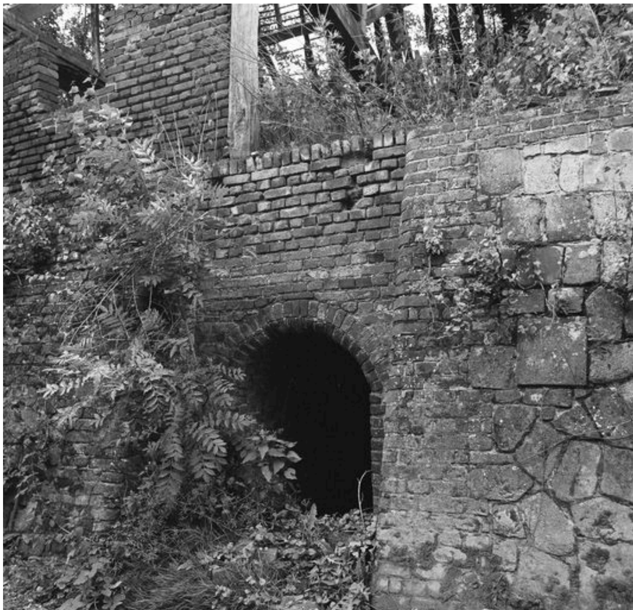
Détail d'un alandier du four Hoffmann.
