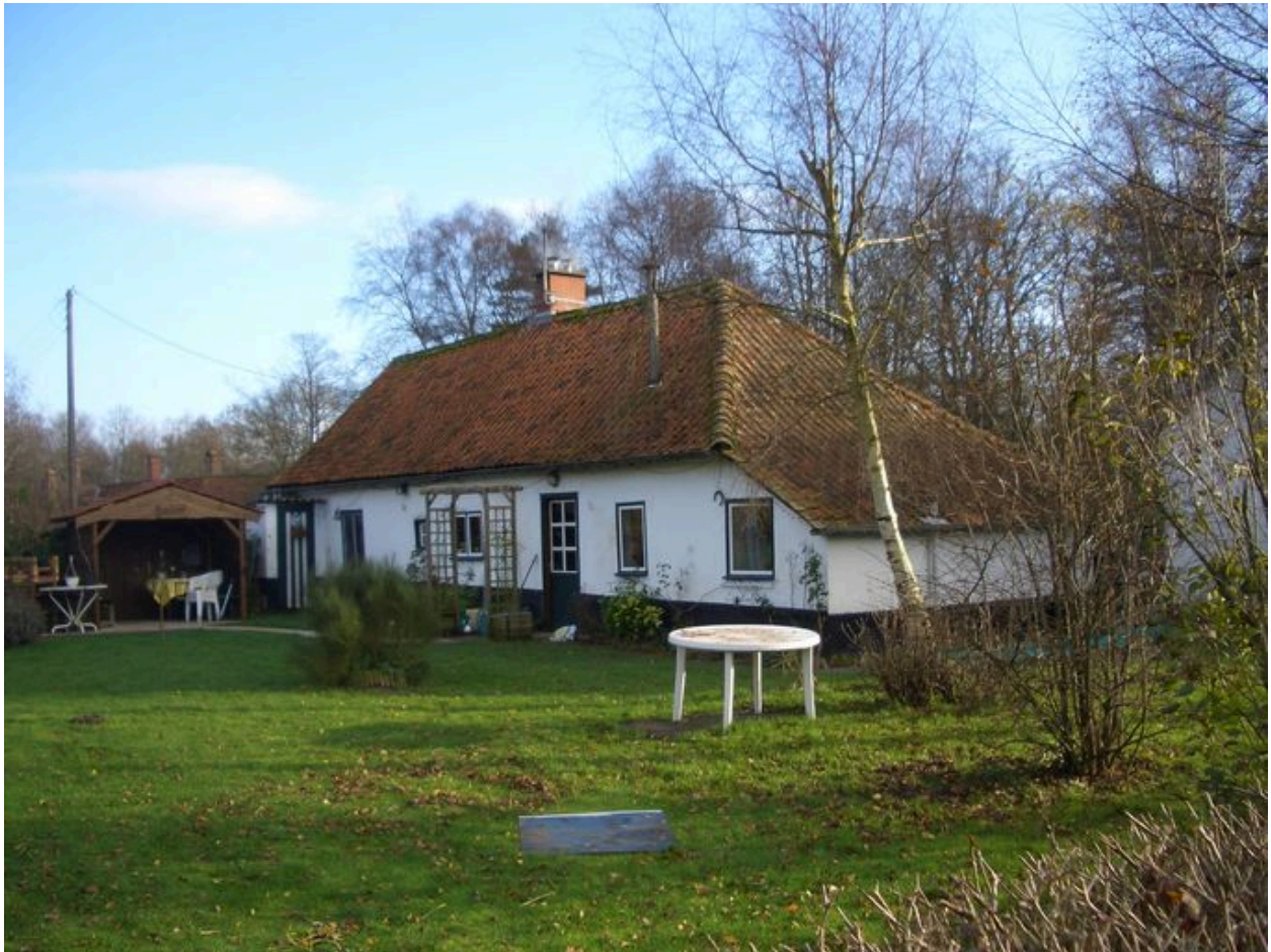
Vue postérieure du logis.
