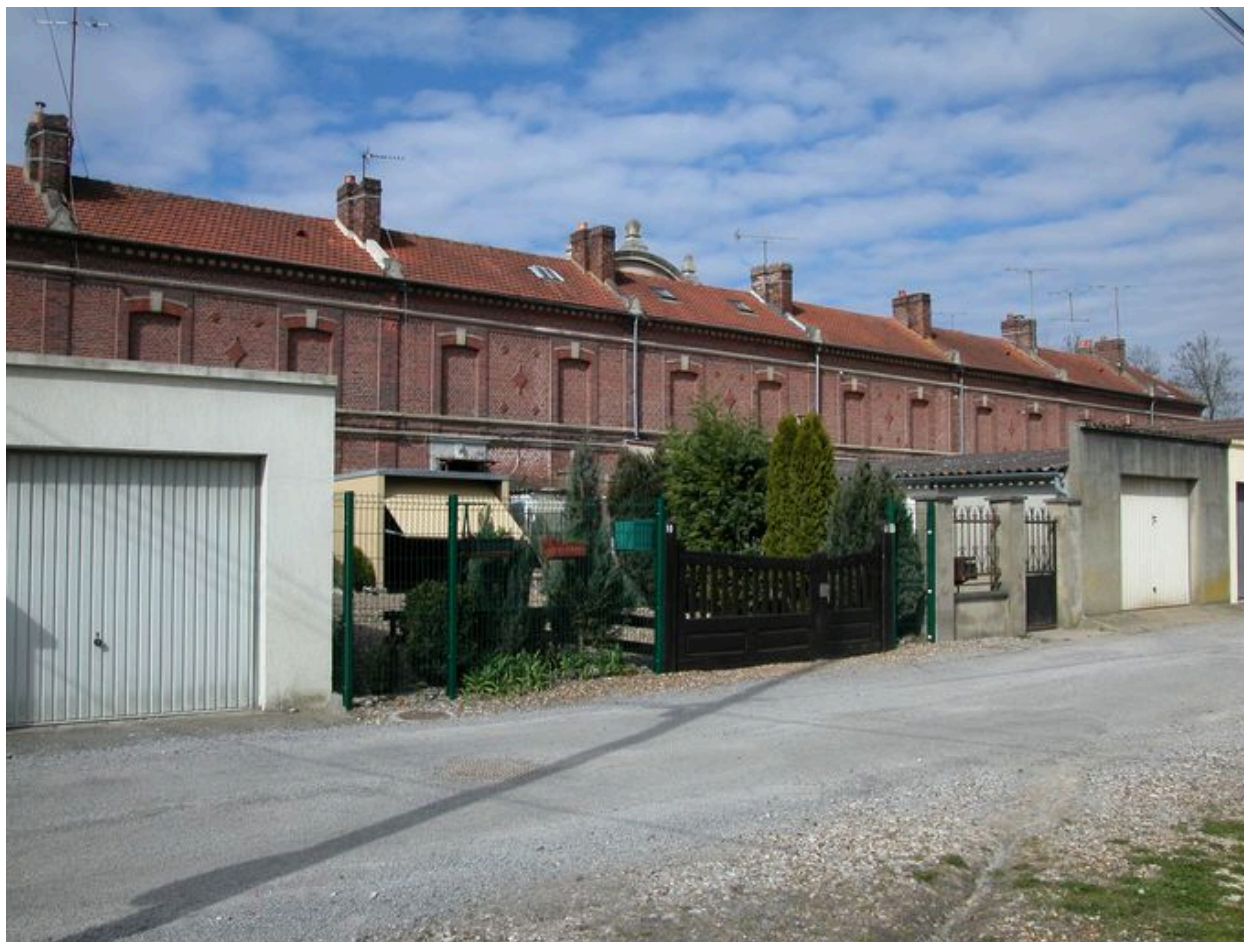
Corps de bâtiment nord, façade postérieure.
