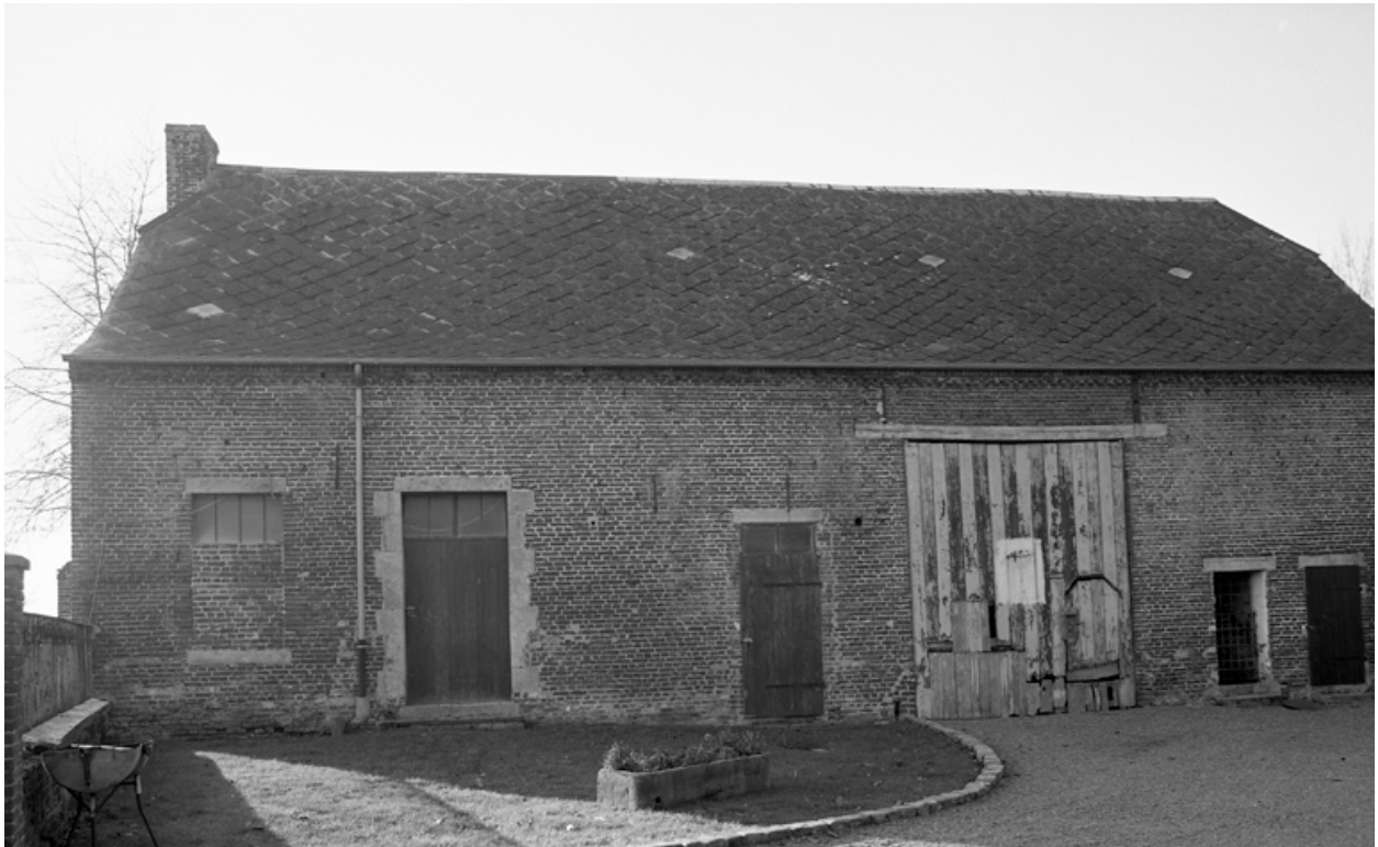
Vue partielle de l'élévation sur cour du bâtiment à usage de grange, étable et remise.
