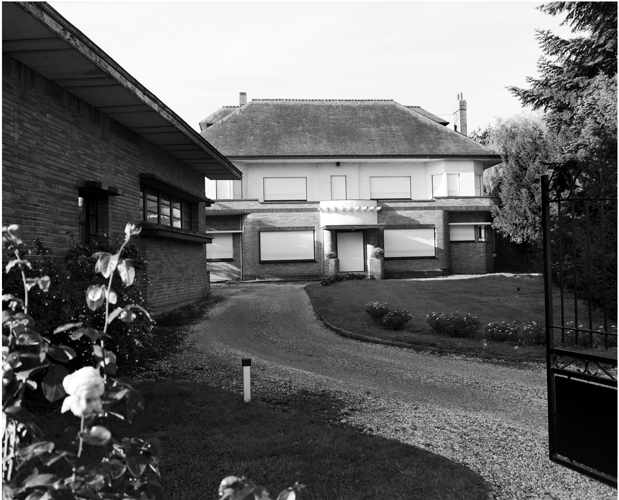
Élévation antérieure de la maison.
