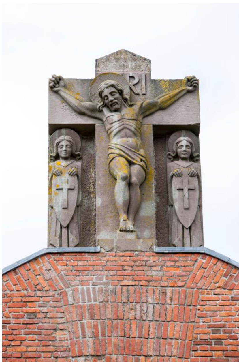
Pignon sud. Christ en amortissement.
