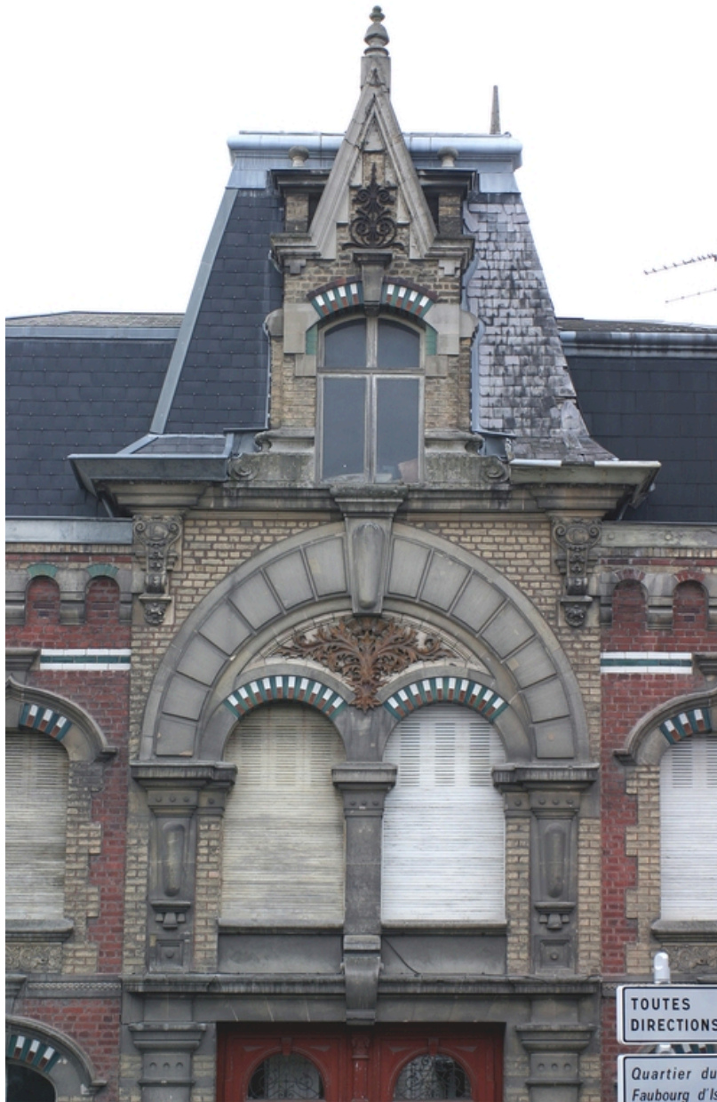
Façade, 6 place du Général Foy : détail.
