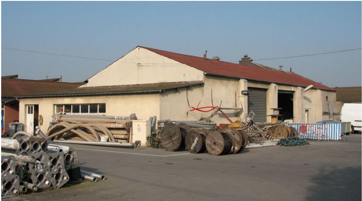
L'ancien cinéma intégré à l'atelier municipal.
