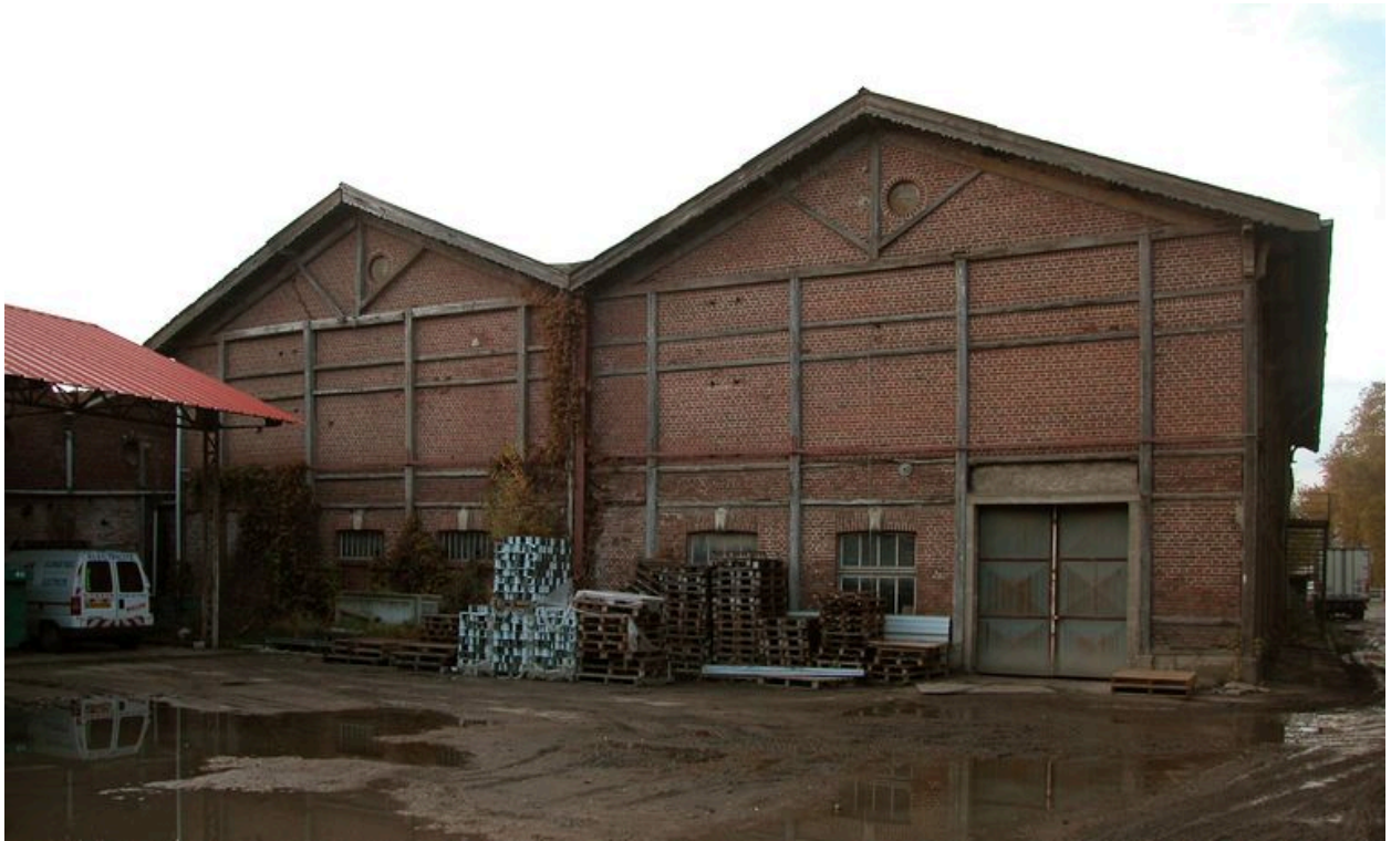
Façade sud des séchoirs.
