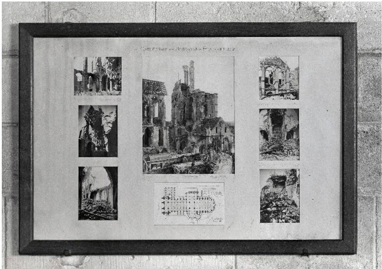
Vue du tableau présenté à l'entrée de la cathédrale, rappelant l'état du monument à la fin de 1918 (2e quart du 20e siècle).
