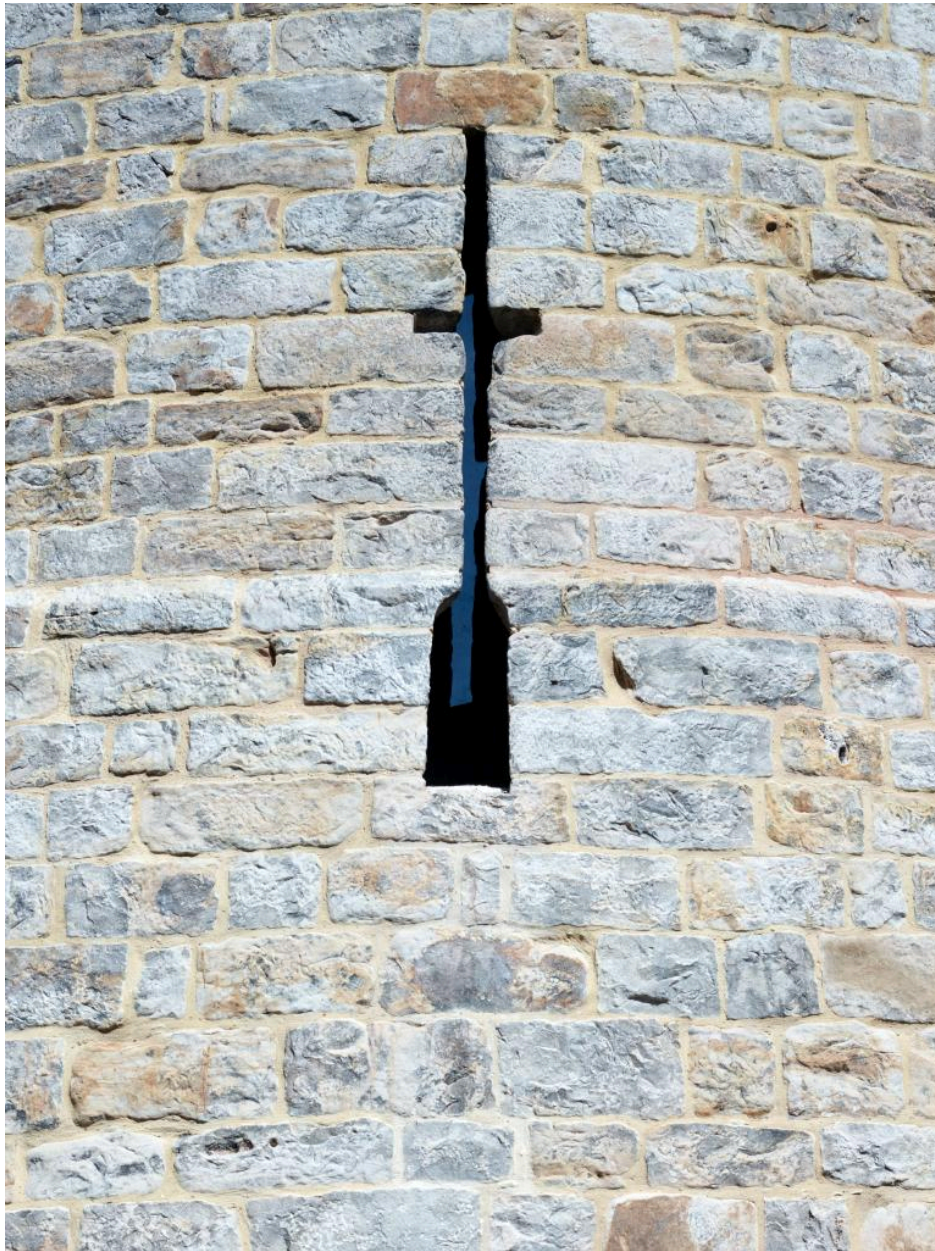
Vue de détail de la cannonière sud, prise depuis le parking.
