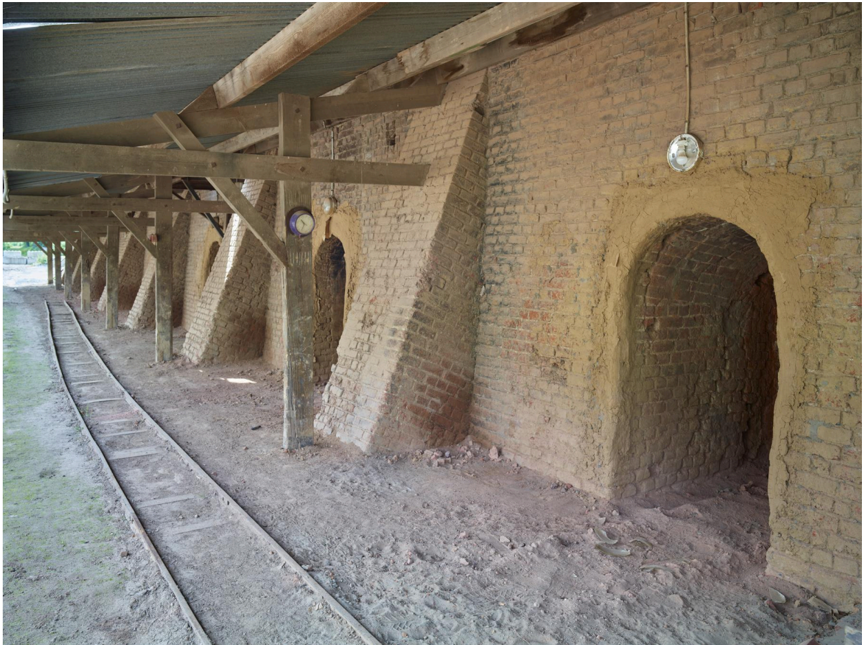
Four Hoffmann. Voie étroite et accès de chargement/déchargement des briques.
