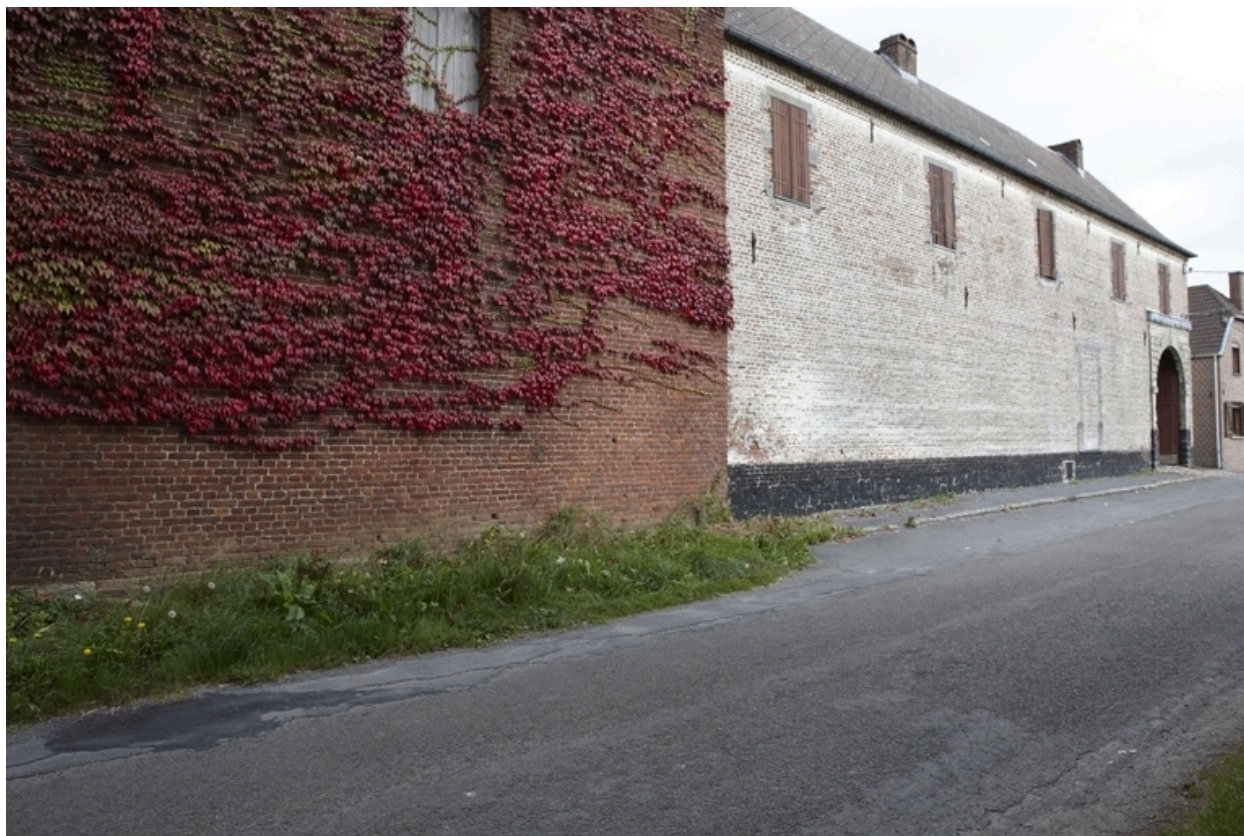
Vue de l'élévation sur rue du logis.
