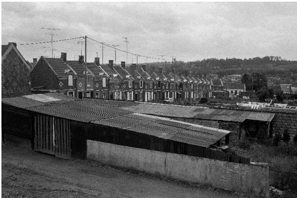
La cité ouvrière (ruelle Rouse), flanc ouest.
