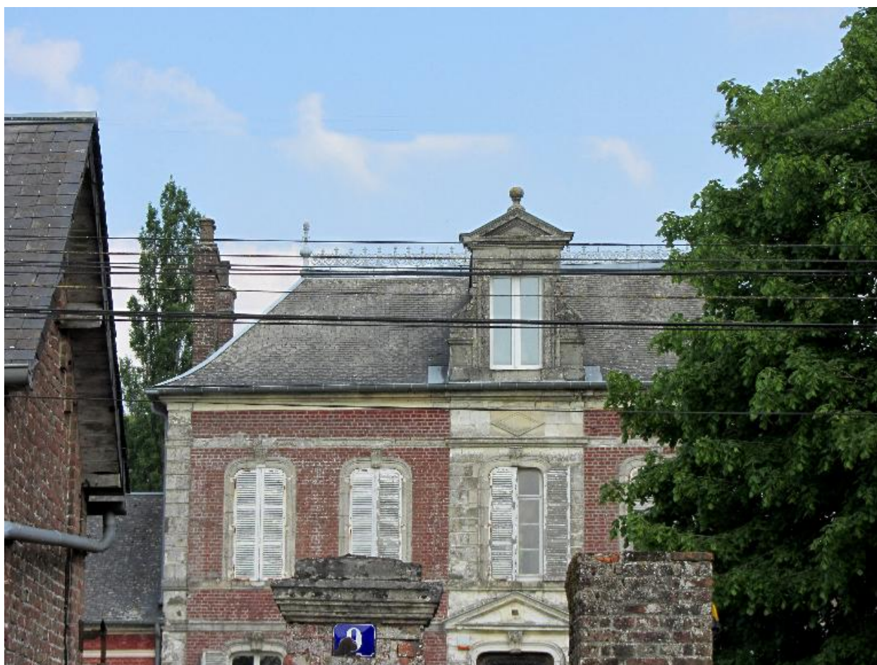
Façade sur cour du logement, vue partielle depuis la rue.
