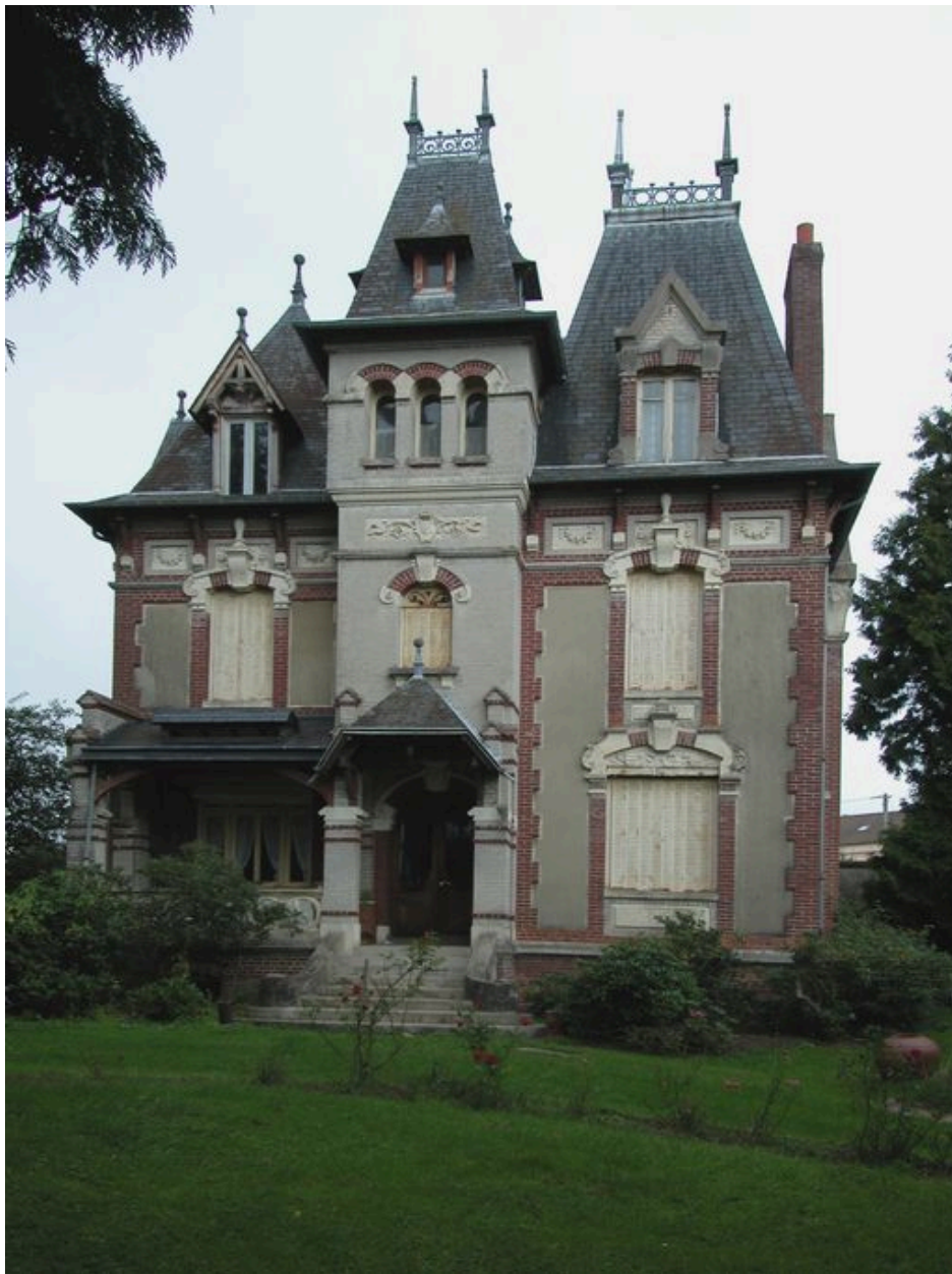
Le logement patronal, façade principale.
