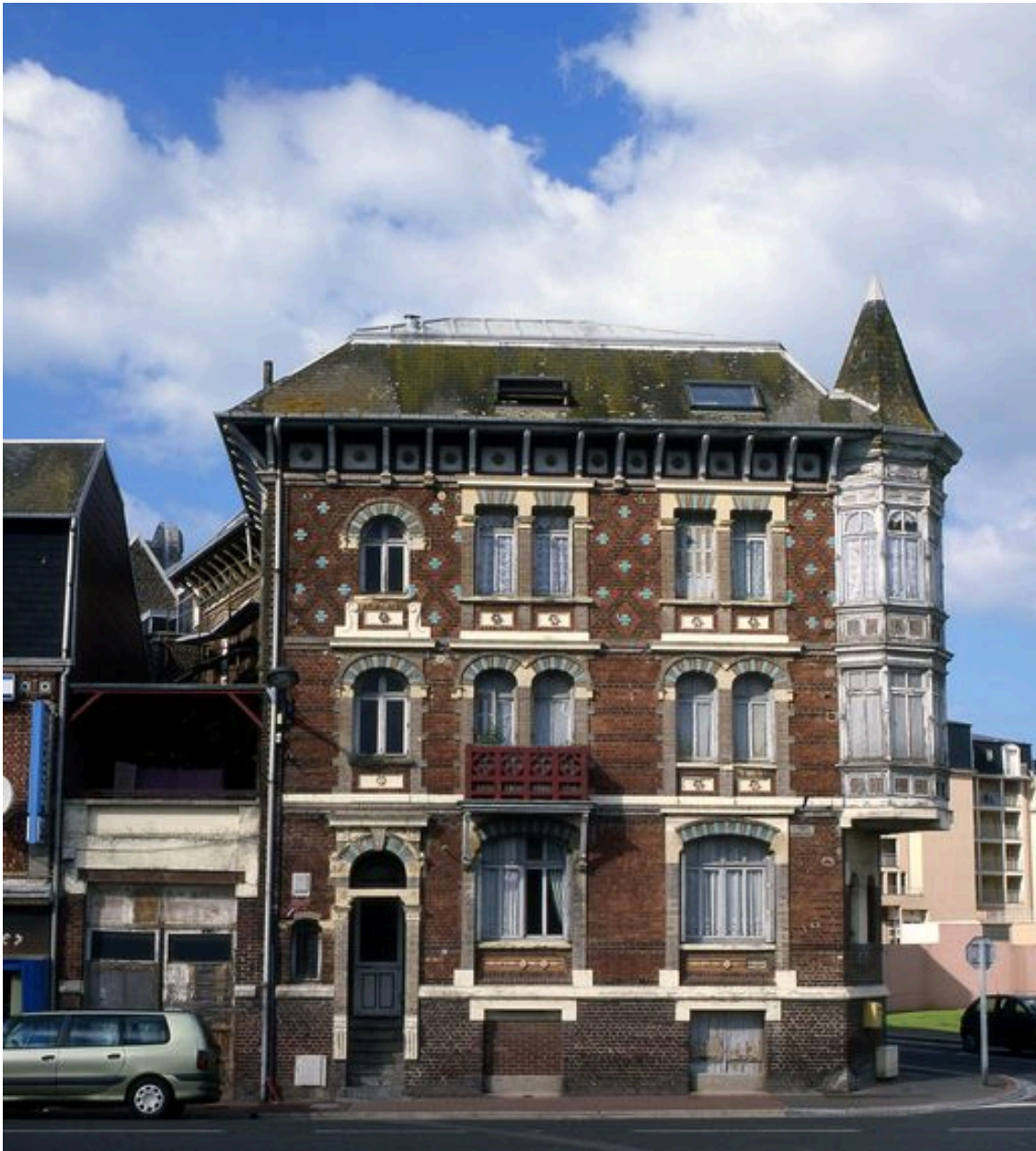
Vue depuis l'avenue du Maréchal-Foch.
