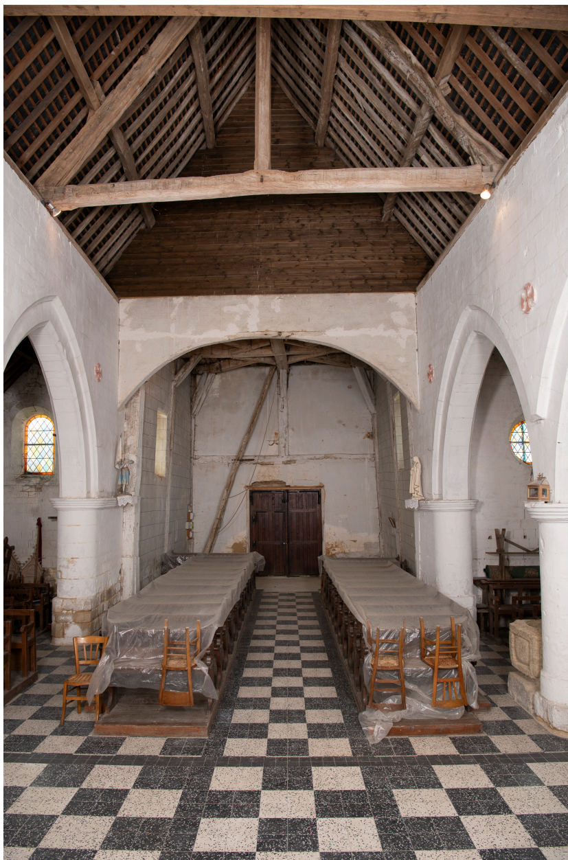
Vue intérieure vers la nef.
