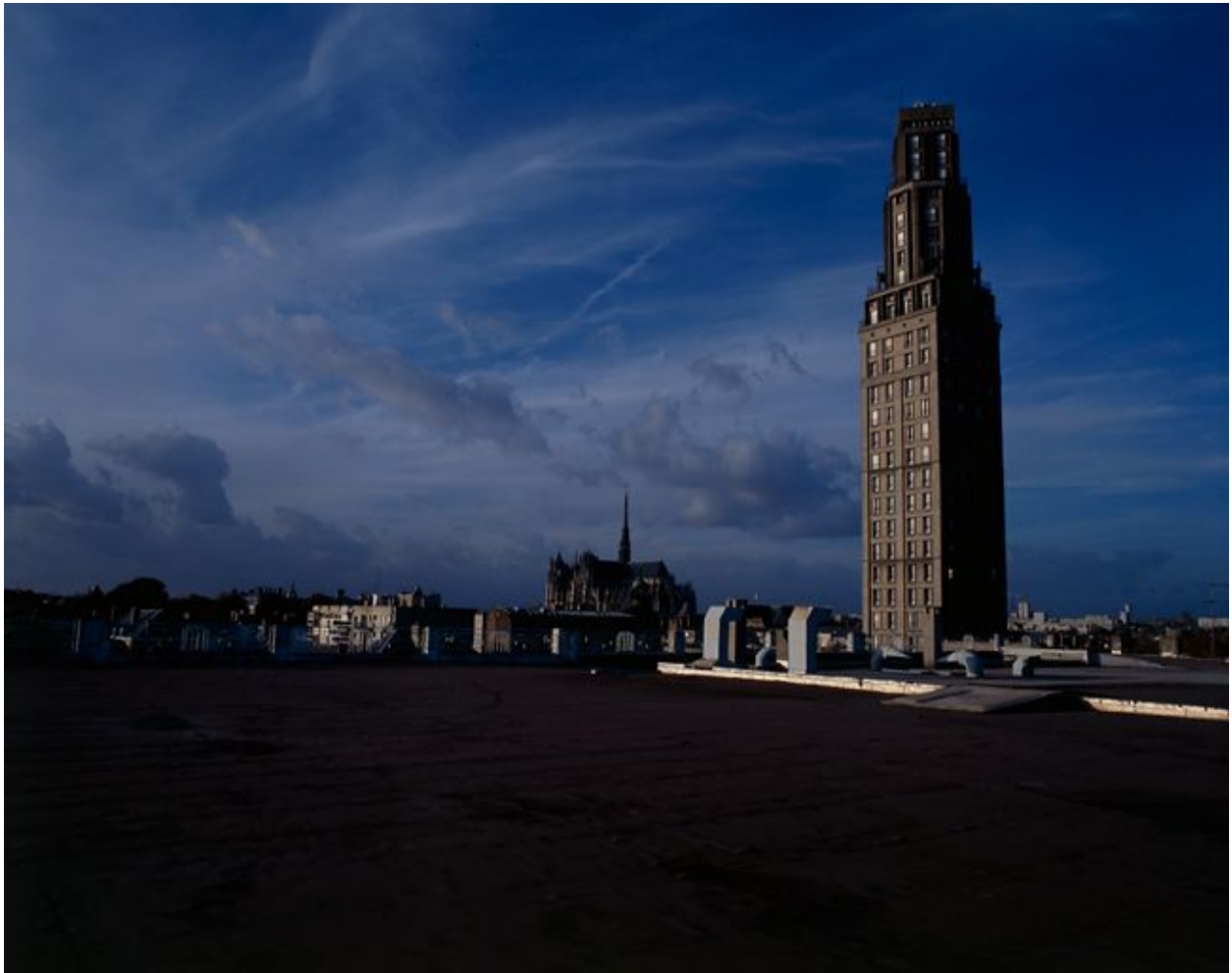
La tour Perret et la cathédrale, vues depuis le toit du garage Citroën.
