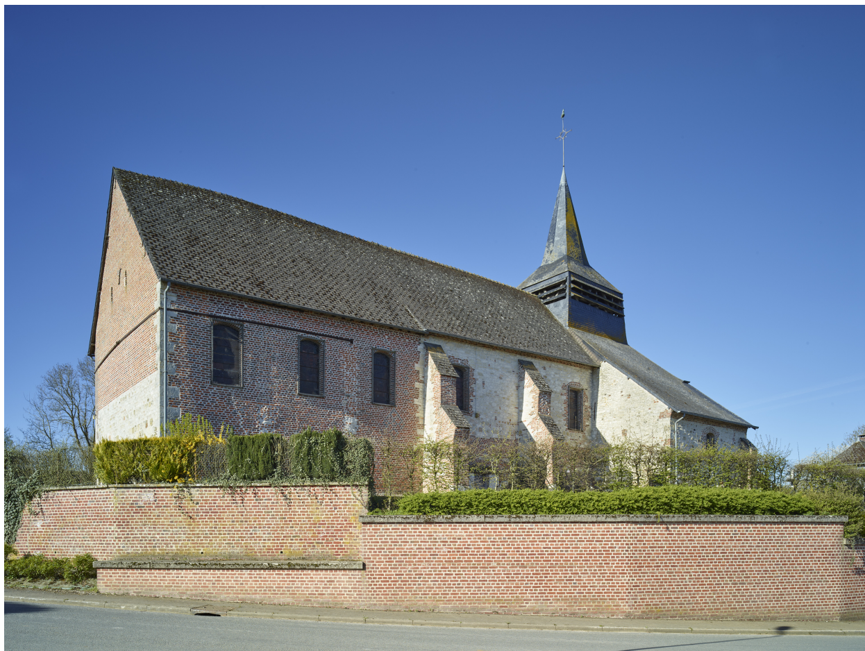
Vue de trois quarts, côté nord est, de l'église.
