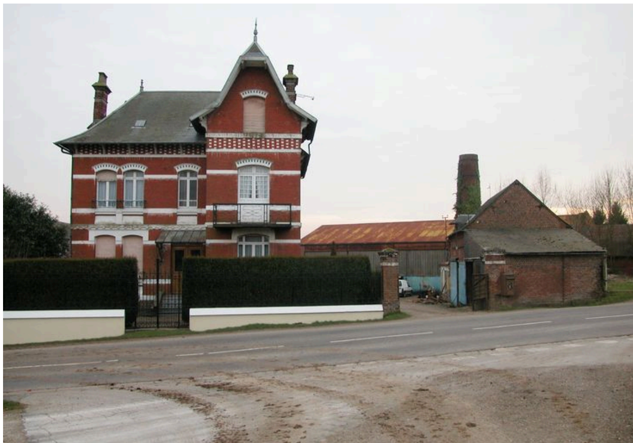
Vue d'ensemble sur rue de la briqueterie et de la maison patronale.
