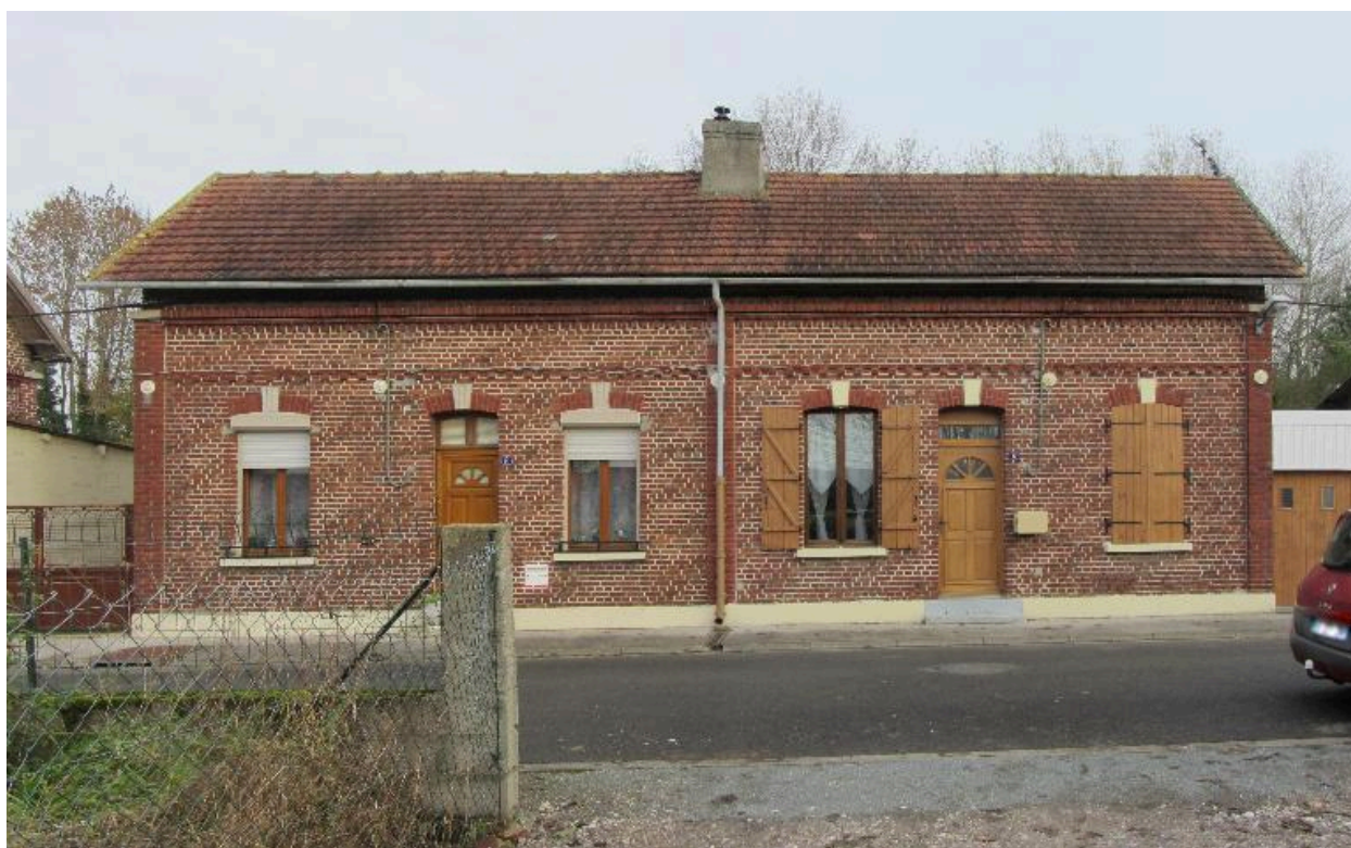
Façade sur rue d'un ensemble de deux logements.
