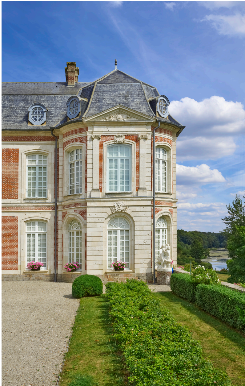
Élévation du pavillon sud, depuis la cour .
