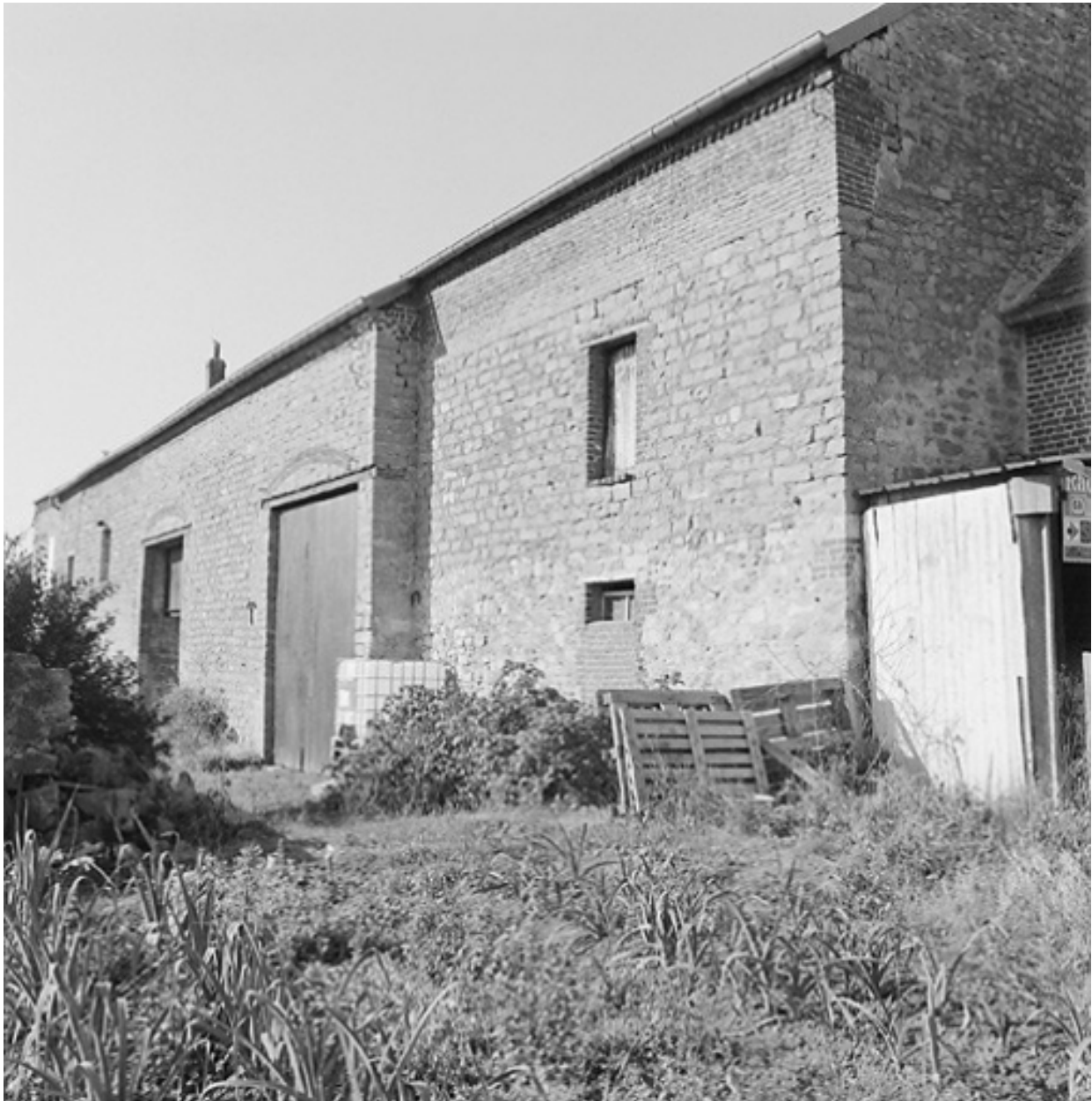
Vue de l'élévation postérieure.
