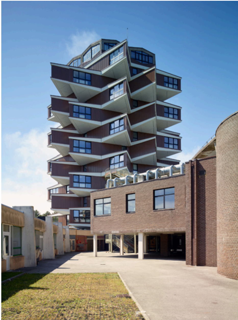
Vue générale depuis le sud est, de la tour de l'internat et du bâtiment des nouvelles cuisines pédagogiques.
