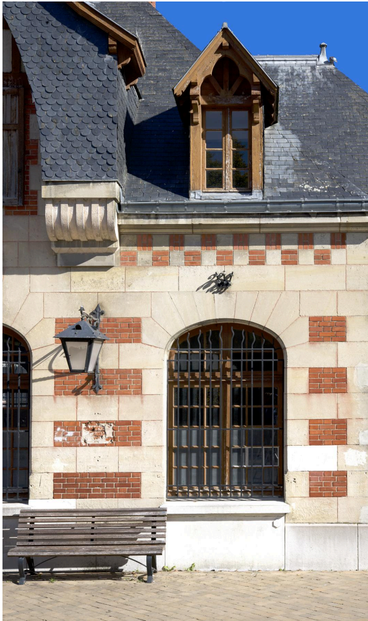
Détail d'une des ouvertures en plein cintre au rez-de-chaussée de la façade principale.
