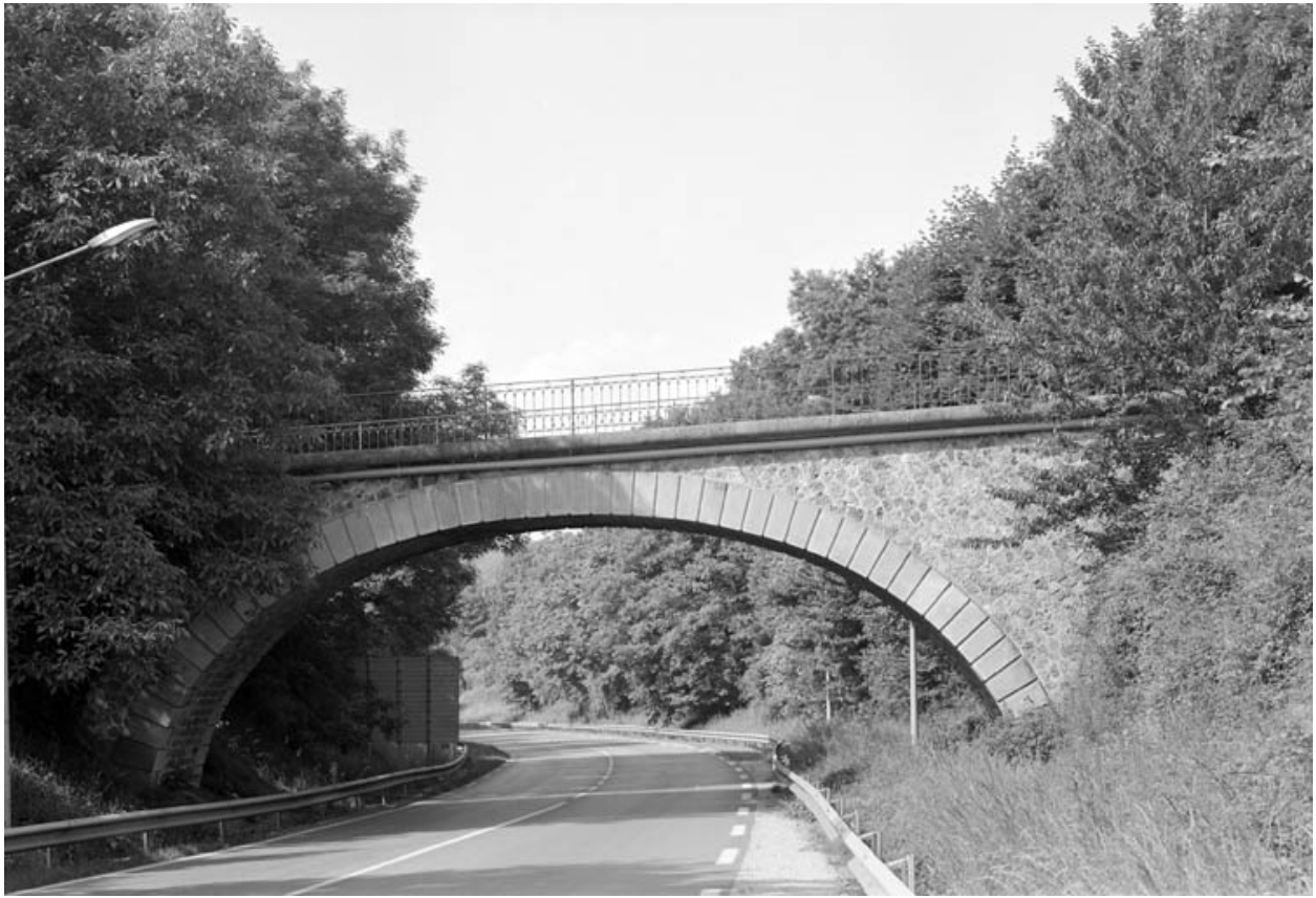
Pont au-dessus de l'ancienne ligne de chemin de fer vers La Ferté Milon (actuelle rocade).
