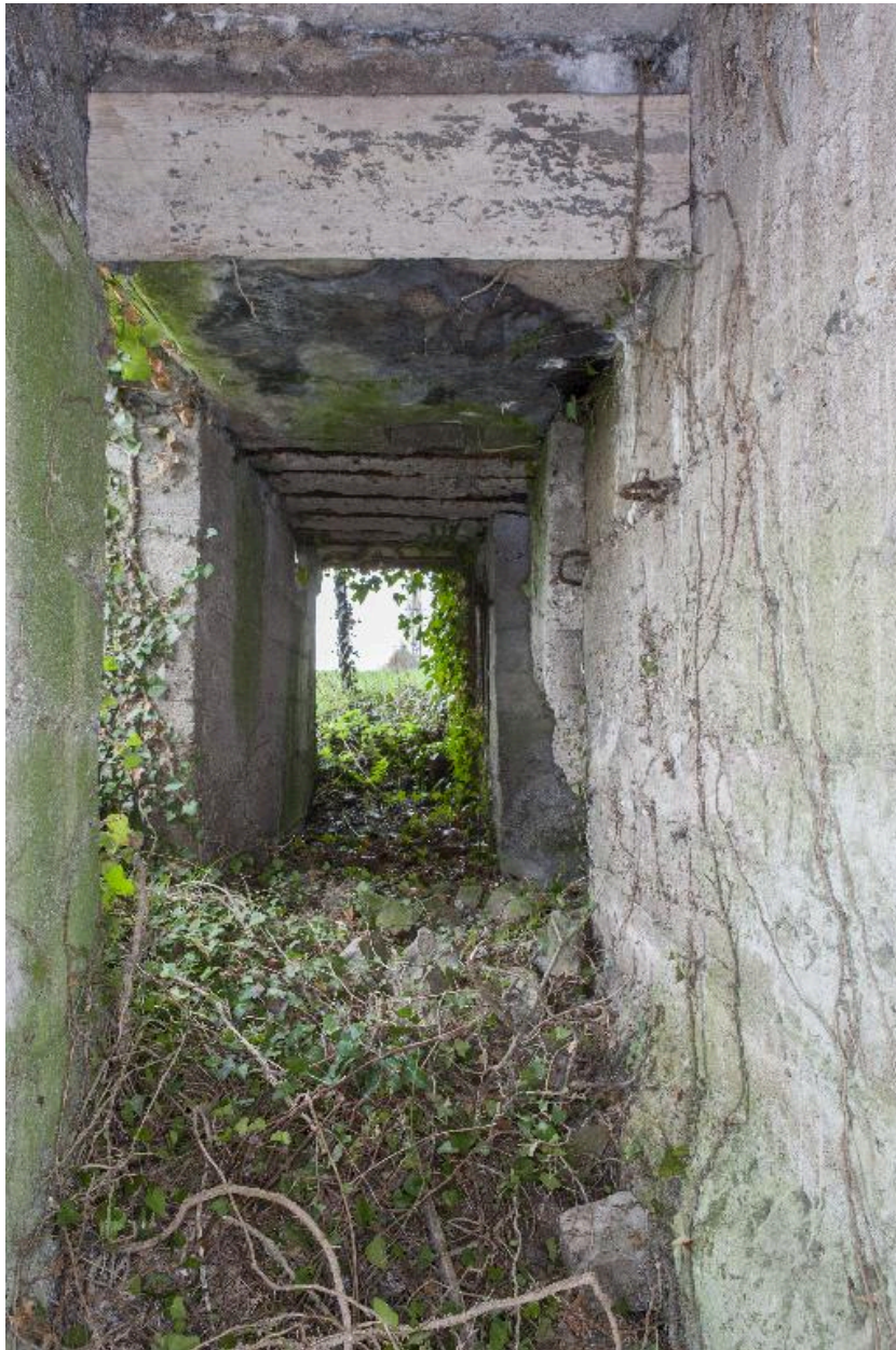
Couloir de distribution, vers l'ouest
