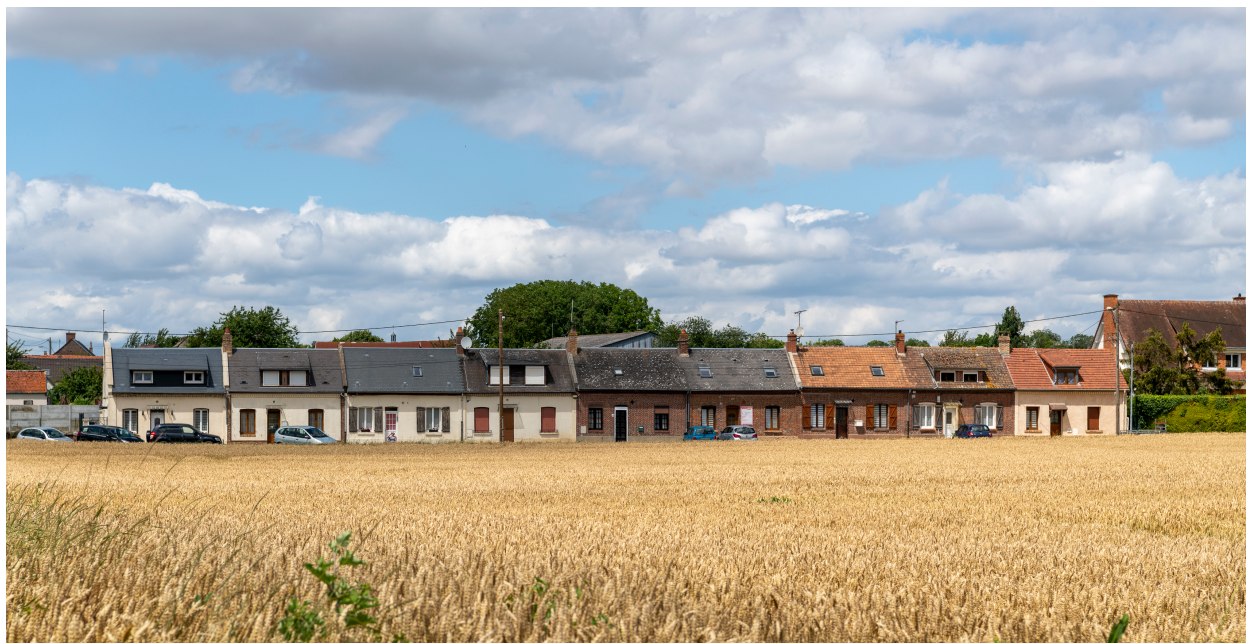
Cité de Paillart, anciens logements des contremaîtres, vue depuis le sud.
