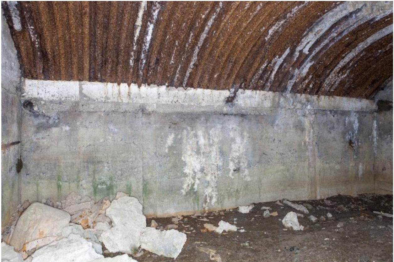
Vue intérieure, mur nord-ouest
