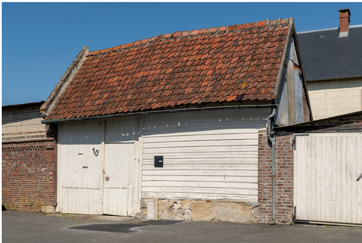
Ancien presbytère. Grange sur rue avec entrée charretière, n°10 de la rue de la Motte, vue depuis l'est.
