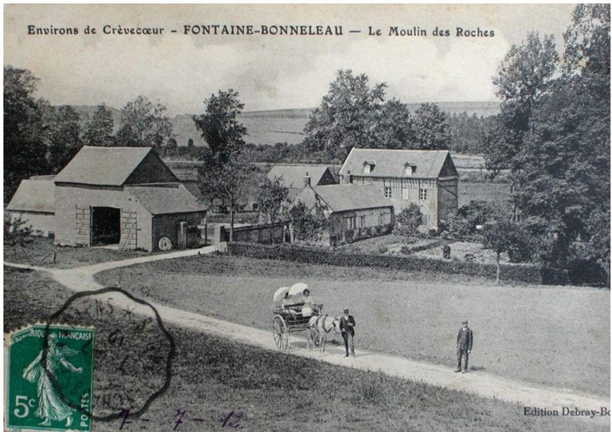
Vue d'ensemble du moulin des Roches en 1912.
