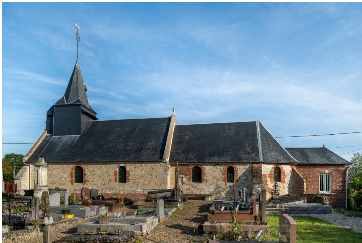
Vue depuis le sud.
