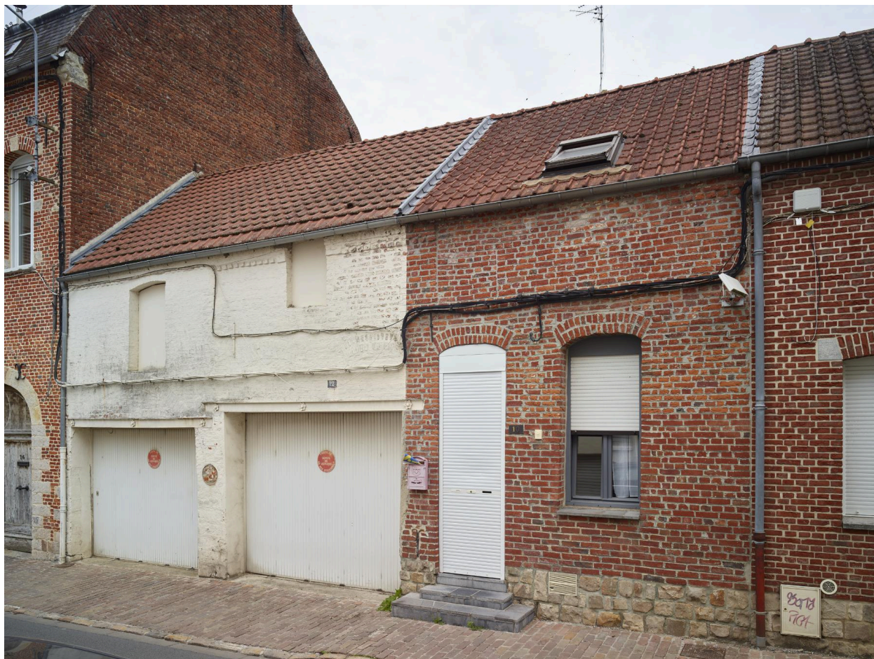
Ancien bâtiment reconverti en garage au début du XXe siècle, reconnaissable à ses linteau en fer décorés de rosettes - 10-12, rue Bouttiaux.
