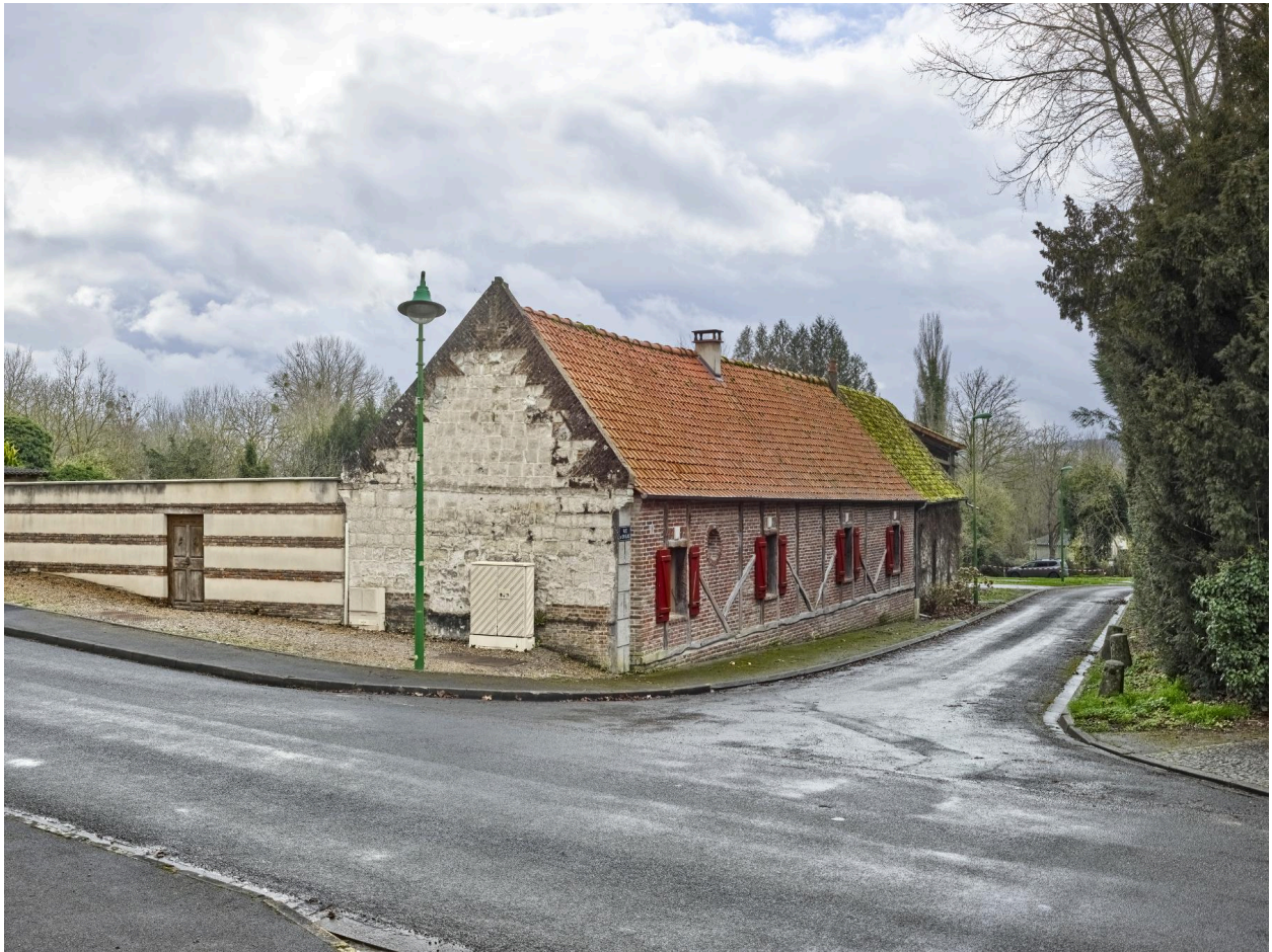
Ancienne ferme entre la rue d'En-Bas et la route d'Abbeville à Longuet, depuis le nord.
