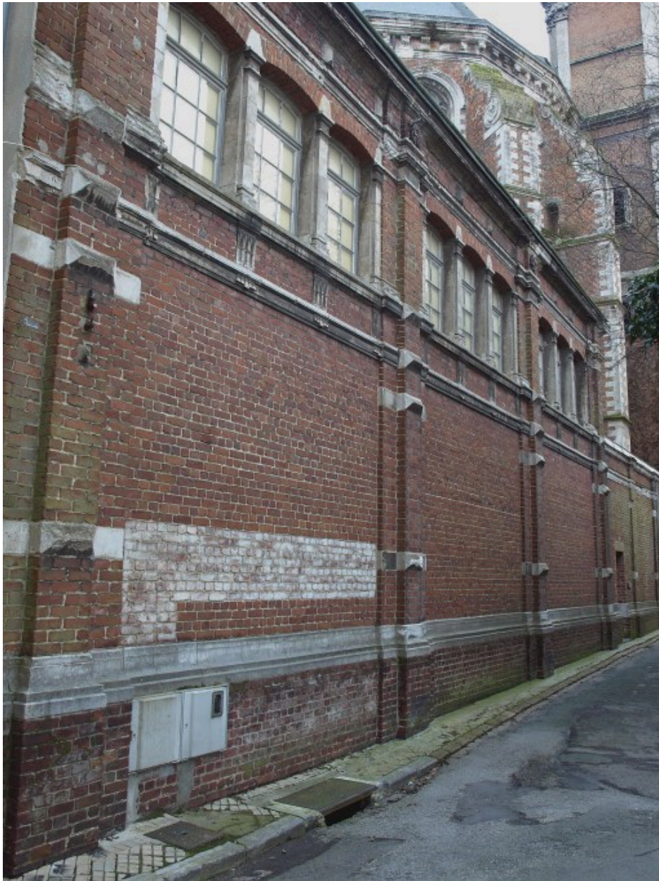
Vue générale depuis la rue au Vent
